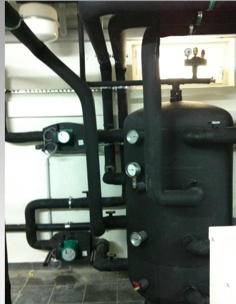
Prüfstände, die mit  $-30^{\circ}\text{C}$  und  $+2^{\circ}\text{C}$  Sole versorgt werden sollten, konnten aufgrund stark schwankender Temperaturen und vieler Störungen verschiedenster Art im Prüfmodus nicht konstant betrieben werden.
